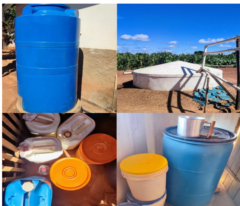
Figura 05 – Reservatórios de água da chuva em um domicílio da zona rural de Francisco Sá, 2025
